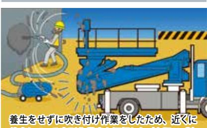
養生をせずに吹き付け作業をしたため、近くに停車している高所作業車を汚損した(上記11-⑨)
